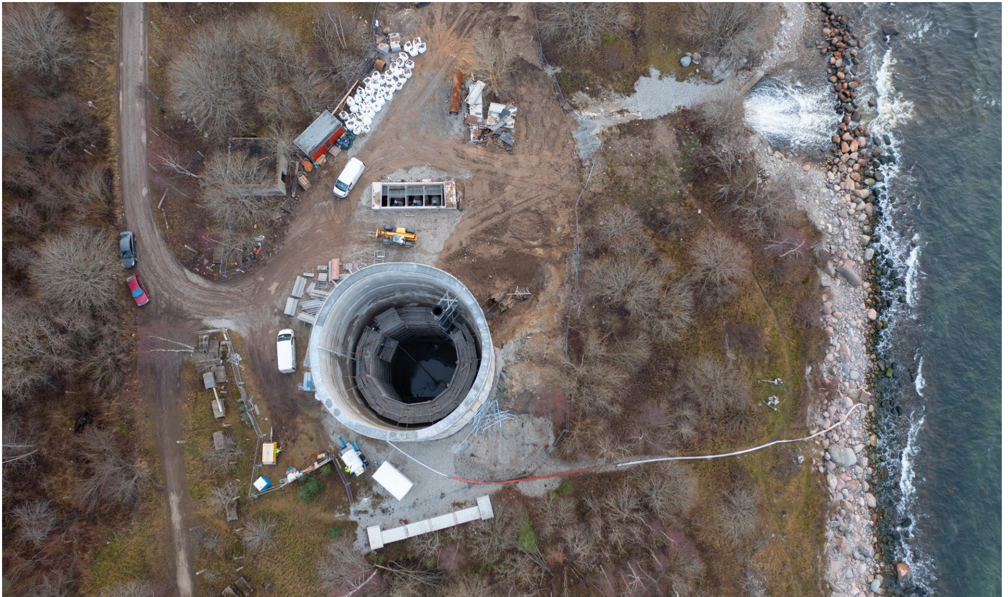
Heitvee rõhutasanduskaevu rekonstrueerimine
